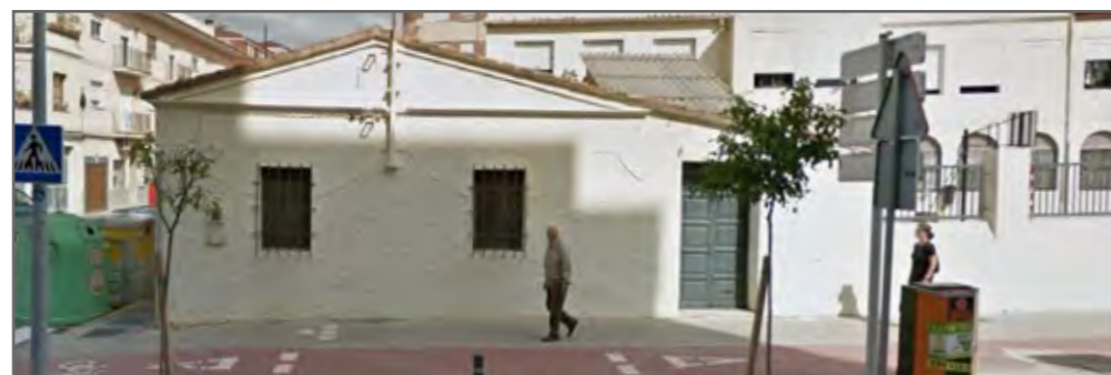
ANTES BEFORE — AVANT VORHER
