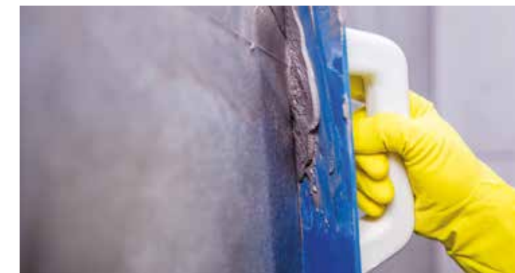
USE A GROUT TROWEL TO AFFIX THE MATERIAL · Utiliza una llana de rejuntado para fijar el material · Utiliser une spatule pour joints pour fixer le joint · Verwenden Sie eine Fugenkelle zum Andrücken des Materials
