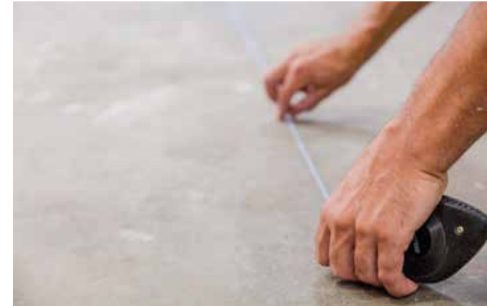
SET THE GUIDELINE · Plantea la línea maestra · Établir la ligne principale · Spannen Sie die Richtschnur
